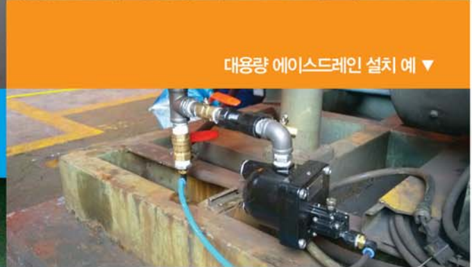
컴프레이샤에 설치된 예 ▼ (수평설치는 위에 물 유입을 원활히 하기 위해 동압관을 연결함)
